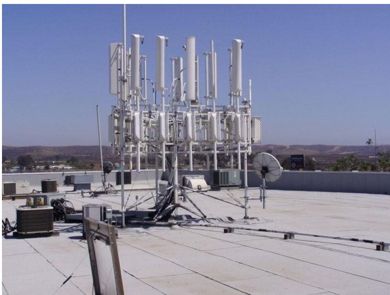
Figura A.b.3: Marco triangular penetrante personalizado con montaje de trípode
