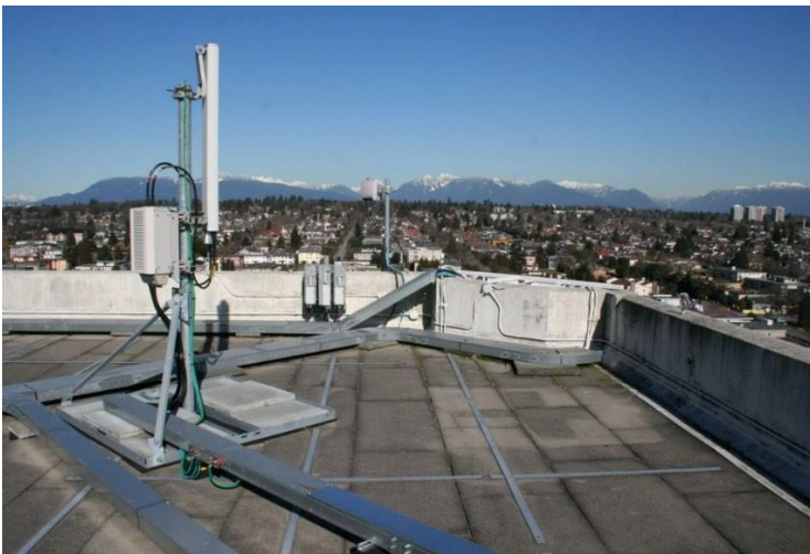
Figura A.b.6: Montaje de trípode lastrado no penetrante
