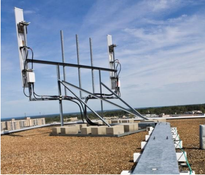
Figura A.b.5: Montaje de trineo lastrado no penetrante
