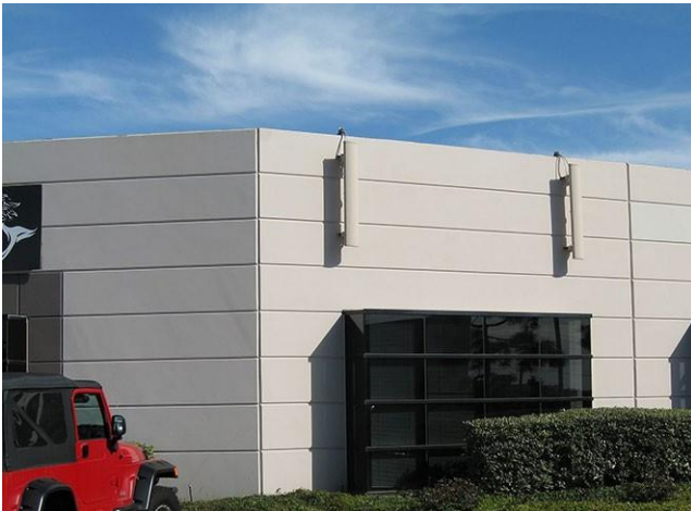
Figura A.a.5: Soporte de pared para tuberías instalado en la pared de un edificio
