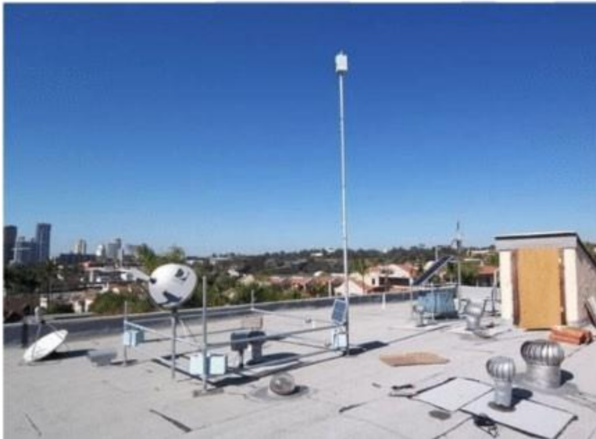
Figura A.b.1: Montaje penetrante personalizado que soporta equipo de radio y plato
