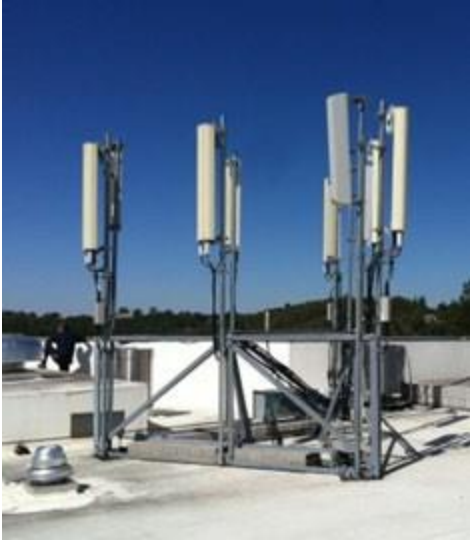
FiguraA.b.7: Montaje triangular lastrado no penetrante
