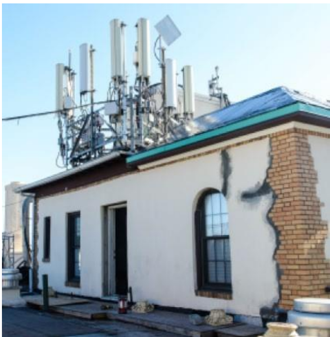
Figura A.b.4: Montaje de techo penetrante personalizado instalado en el techo del ático
