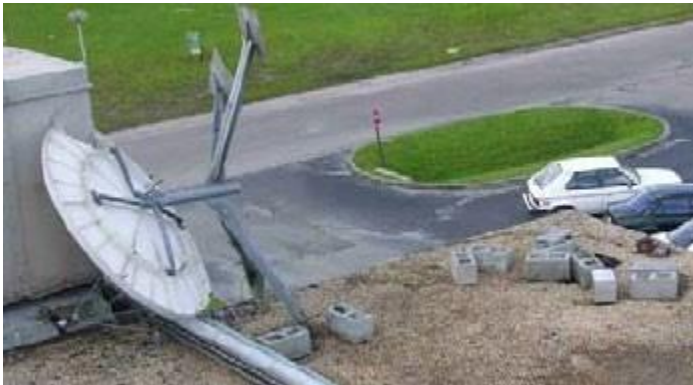
Figura B.2: Antena parabólica en la azotea volcada por no tener suficientes bloques CMU y bloques no colocados correctamente.
