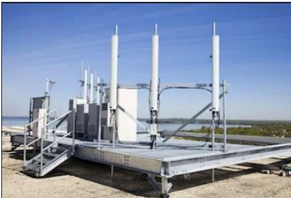
Figura A.c.2: Montaje penetrante instalado en la plataforma del equipo
